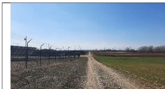
Jobbra a tervezett 1. számú terület, tőle balra már megvalósult naperőmű park. A földút kiépítésre kerül a kapcsoló állomás és az alállomás megközelítésére.
